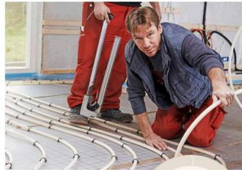
Bei der Installation der Flächenheizung mit reversiblen Wärmepumpen sollte der Fachmann sowohl den effizienten Heiz- als auch den Kühlbetrieb beachten.
