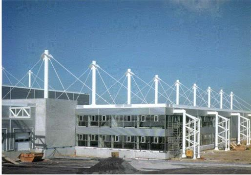
„Mit der nach außen gelegten Tragkonstruktion erreichten wir beispielsweise eine Volumenersparnis von ca.10 000 m<sup>3</sup> und konnten gleichzeitig gestalterische Akzente setzen“.
