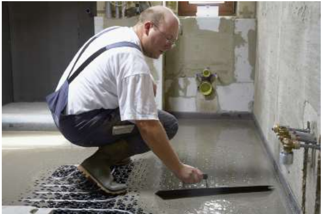
Abbildung 4 – Der Hydraulikblock (ganz rechts im Bild) der Wärmeübergabe ermöglicht die getrennte Versorgung von Badheizkörper und Fußbodenheizung;
