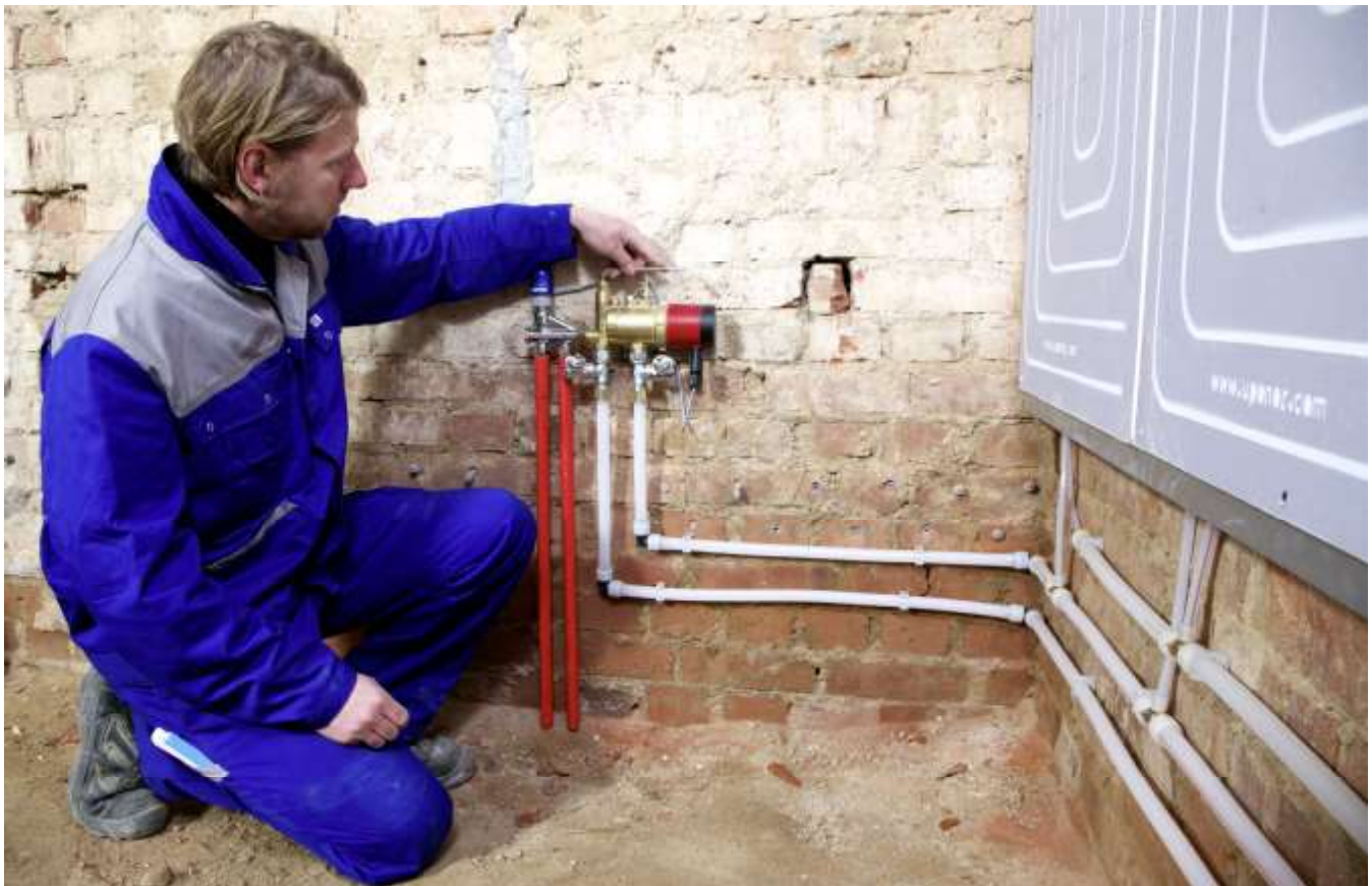
Abbildung 3 – Kleine Heizkreisverteiler mit dezentraler Umwälzpumpe, ermöglichen eine eigenen Heizkreis für ergänzende Flächenheizsysteme;
