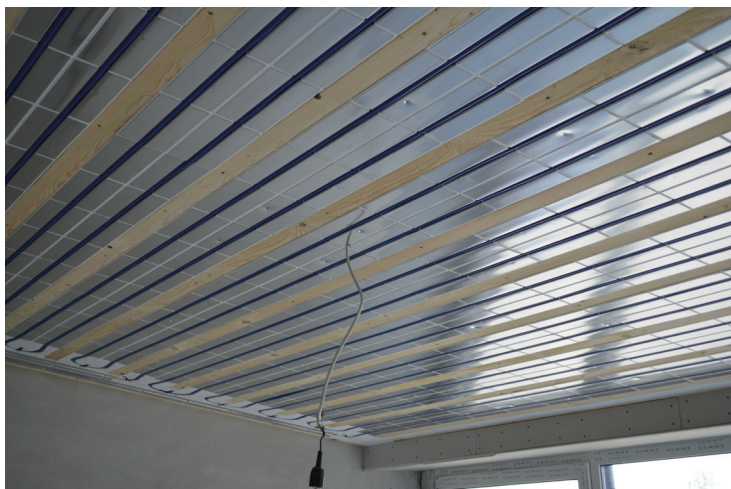
Abbildung 4: Ansicht einer Deckenheizung/-kühlung in Registerbauweise (Trockenbau) mit Lichtauslass vor dem Anbringen der Trockenbauplatten mit Befestigung in der Unterkonstruktion, Quelle: BDH
