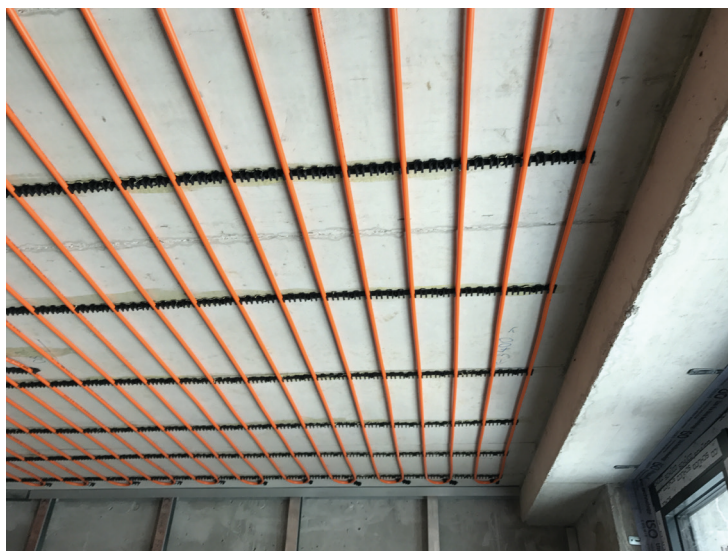
Abbildung 2: Ansicht einer Deckenheizung/-kühlung mit gleichmäßigen Verlegeabständen vor dem Aufbringen der Wärmeverteilschicht (Deckenputz) in Nassbauweise, Quelle: BDH
