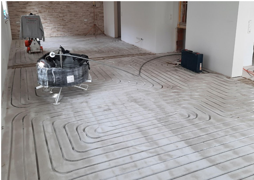
Abbildung 10: Eingefräster Estrich mit eingelegten Systemrohren in einem bestehenden Wohngebäude
