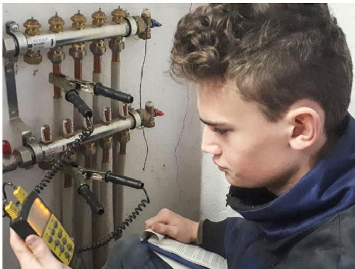
Ermittlung der Temperaturdifferenz zwischen Vor- und Rücklauf mit einem Zweikanal-Temperaturmessgerät.
