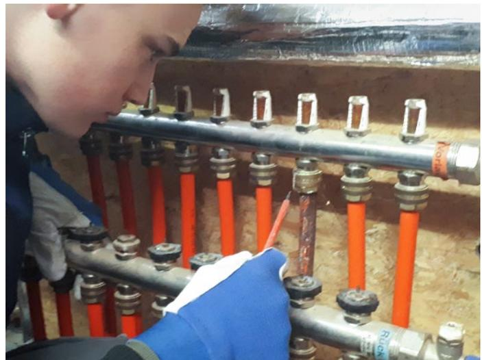
Korrosion ist ein häufiges Problem an alten Heizkreisverteilern.
