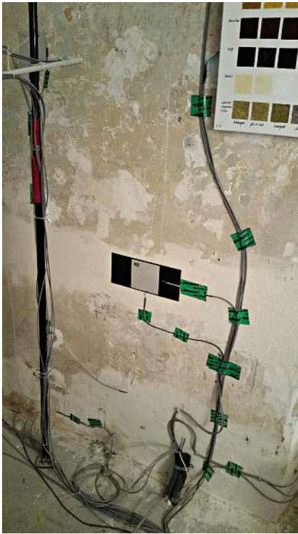
Bild 2: Messaufbau zum thermischen Verhalten von Außenwänden in einem Bestandsgebäude
